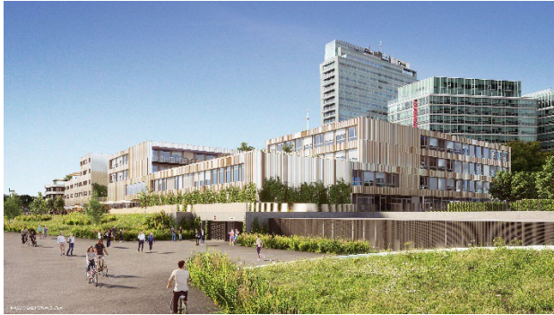
Abbildung 2: Im ersten Bauabschnitt entsteht der DC Bildungscampus © OLN
